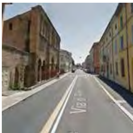
Il tratto di Via Di Roma riaperto sperimentalmente nei mesi di chiusura del Ponte Teodorico
