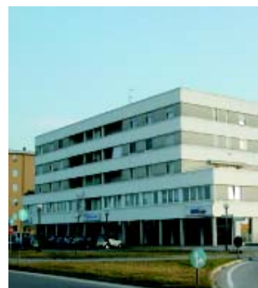
Nella foto: la sede operativa di Form.Art, in Viale Newton 78 a Ravenna
